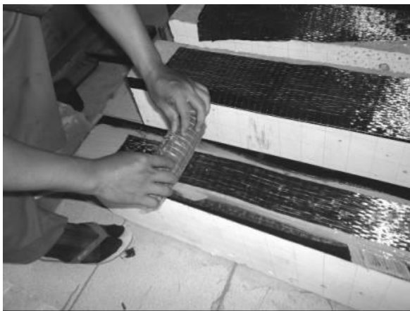
Gambar 6. Pemasangan CFW pada benda uji
