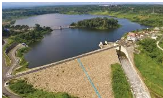
Gambar 2. Pintu Air di Waduk Jatibarang
