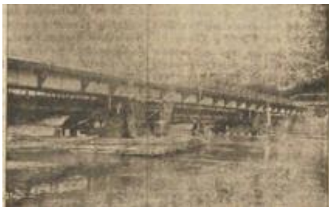
Gambar 3. Renovasi Jembatan Lama (Sumber: Stufkens, 1915)
