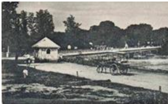
Gambar 2. Jembatan Lama setelah Dibuka (Sumber: Raap, 2015: 221)
