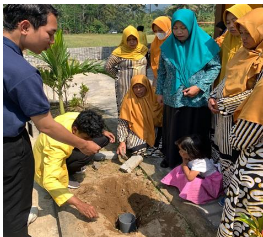
Gambar 4. Pemasangan Pipa Paralon Biopori (Sumber; Dokumentasi Pribadi)
