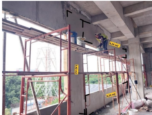
Gambar 3. Volume pekerjaan acian di area A (Sumber : dokumen penelitian, 2024)
