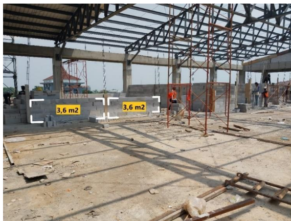
Gambar 1. Volume pekerjaan bata ringan di area A (Sumber : dokumen penelitian, 2024)
