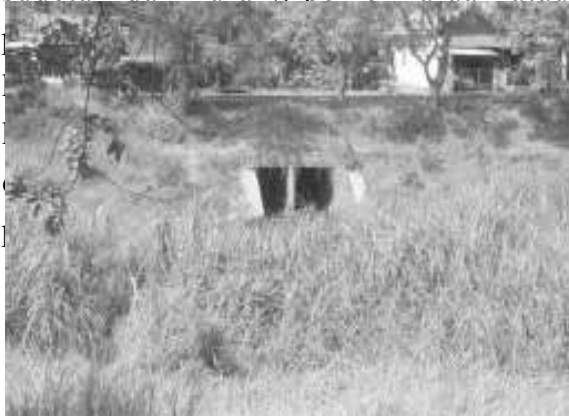
Gambar 4. Pendangkalan di depan Pintu Sudetan di Kelurahan Barusari
