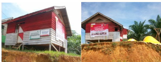
Gambar 3. Bangunan Madrasah Ibtidaiyah Darul Furqon (Sekolah Tapal Batas) di Desa Sungai Limau (Dokumentasi Pribadi, 2018).
