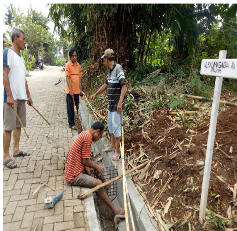
Gambar 5. pemasangan saringan sampah
