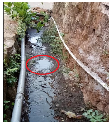
Gambar 3. penerapan bak kontrol sampah
