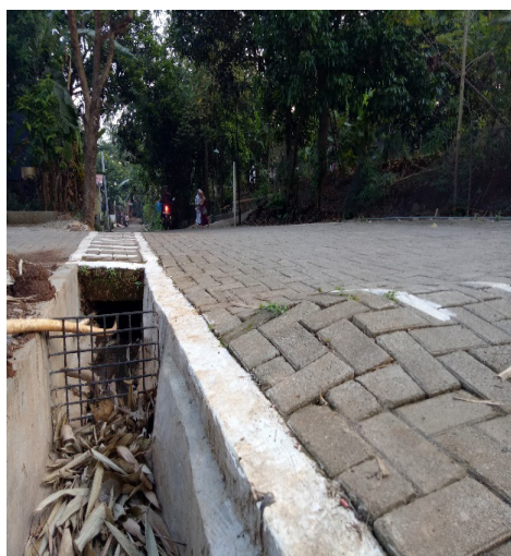
Gambar 6. bukti saringan sampah mulai berfungsi menghambat sampah yang ada di selokan
