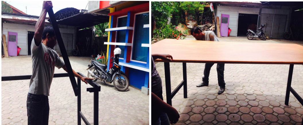
Gambar 2. Pembuatan dan Pemasangan Meja Kerja Ergonomis
