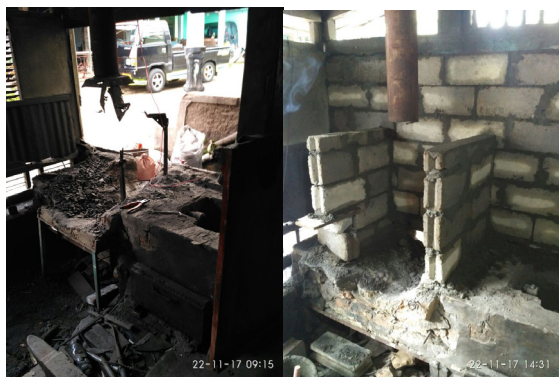
Gambar 2. Kondisi tungku sebelum direnovasi
