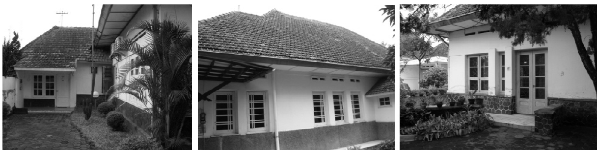
Gambar 6. Penutup Dinding Batu Belah pada Bangunan Rumah Tinggal Kolonial di Sagan Sumber: Analisis peneliti, 2011
