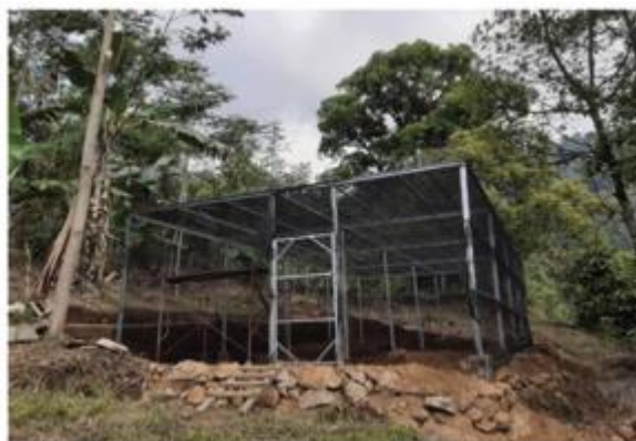
Gambar 1. Kondisi Rumah Pembibitan Mitra
