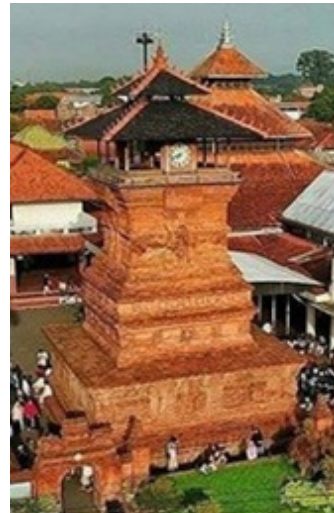
Gambar 3: Foto bentuk bangunan menara Masjid Menara Kudus (Foto Dokumentasi Tim Peneliti)
