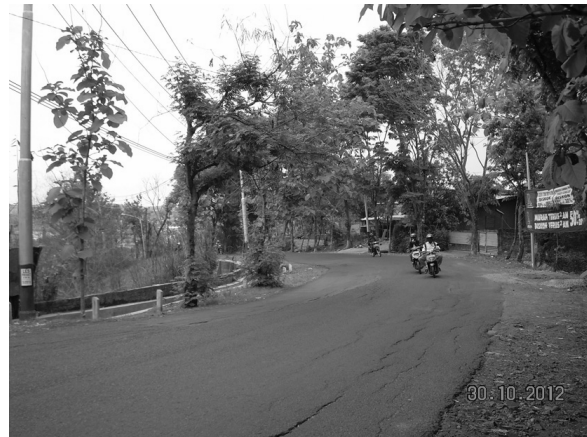
Gambar 5. Kondisi lereng Deliksari
