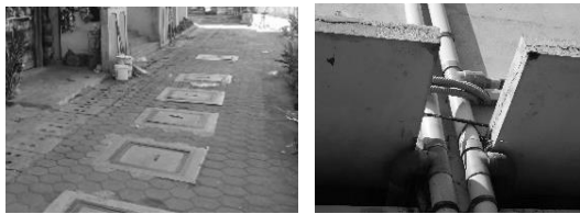
Gambar 17. Infrastruktur Air Kotor
