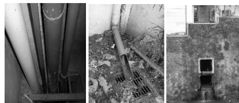
Gambar 7. Infrastruktur Air Kotor
