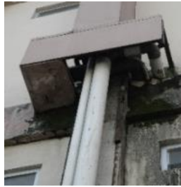
Gambar 27. Infrastruktur Air Kotor
