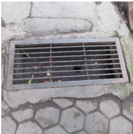
Gambar 15. Saluran drainase air hujan Sumber: dokumentasi tim peneliti, 2015
