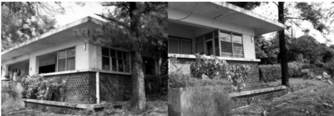
**Gambar 10.** Material Batu alam dan atap dak beton
