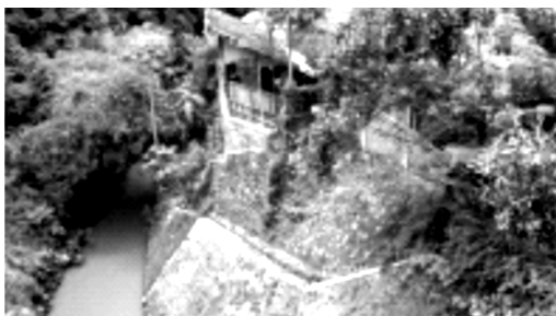
Gambar 9. Bangunan di atas tanggul Sungai Gajah Wong
