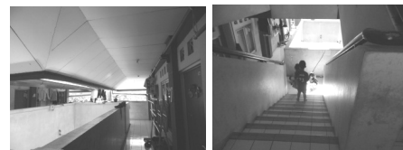
Gambar 28. Kondisi pencahayaan pada ruang-ruang koridor dan ruang-ruang sirkulasi.
