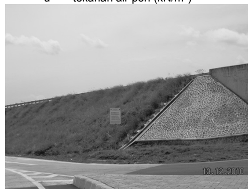
Gambar 2. Aplikasi sistem vetiver pada timbunan jalan pada jalan Tol Semarang-Solo dan pertumbuhannya pada musim hujan dan kemarau. (Dokumentasi Hanggoro Tri Cahyo A, tahun 2010 s/d 2012)
