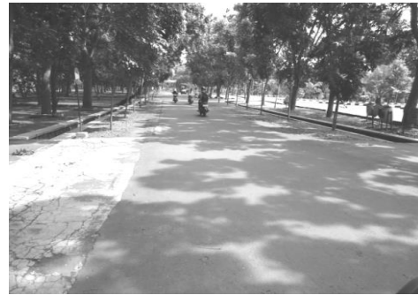
Gambar 10. Kondisi jalan di samping Auditorium
