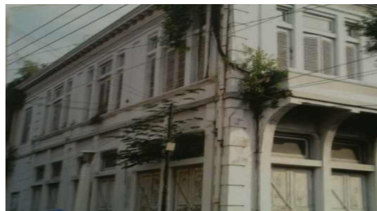
Gambar 1. Bangunan Semarang Contemporary Art Gallery sebelum direnovasi tahun 2007
