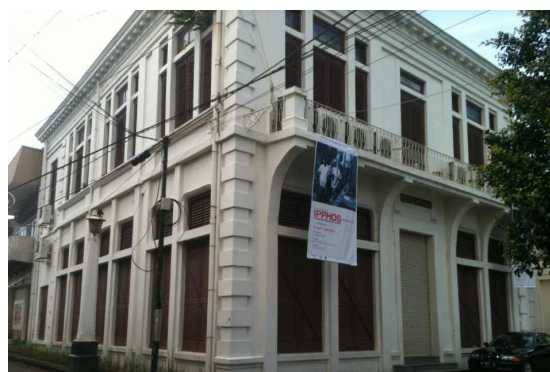
Gambar 2. Bangunan Semarang Contemporary Art Gallery setelah direnovasi
