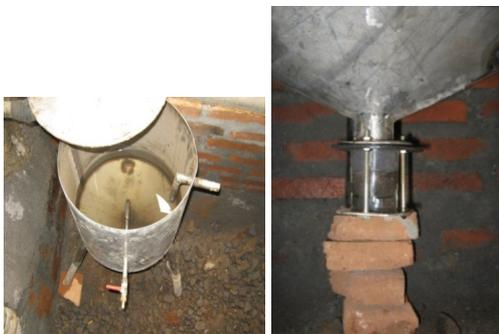
**Gambar 4. (kiri) Alat pemisah minyak tampak atas, (kanan) pengintai minyak berada di bagian bawah alat pemisah minyak**
