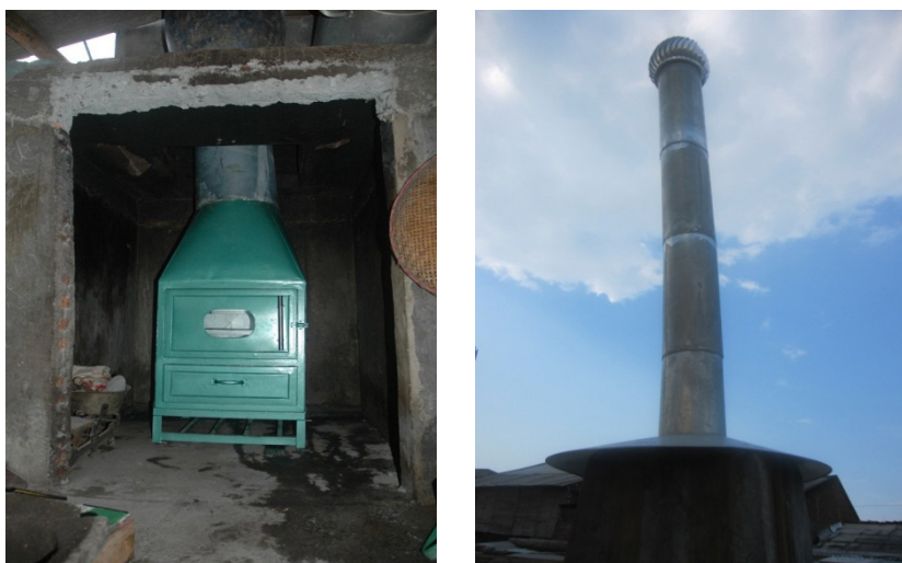
Gambar 2. Cerobong dan ventilator asap pemanggangan ikan
