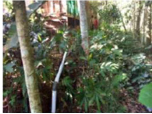
**Gambar 12. Pemasangan saluran air buangan dari rumah warga**
