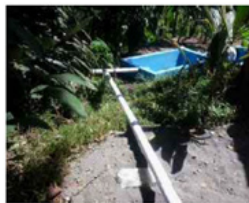
Gambar 12. Pemasangan saluran air buangan dari rumah warga
