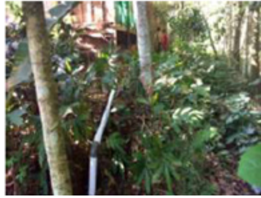
Gambar 12. Pemasangan saluran air buangan dari rumah warga
