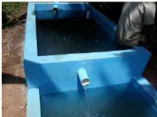
Gambar 14. Pengoperasian unit pengolah
