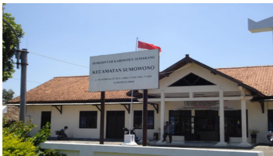
Gambar 1. Kompleks perkantoran wilayah kecamatan Sumowono, (Sumber: Foto Tim Pengabdi, 2014)
