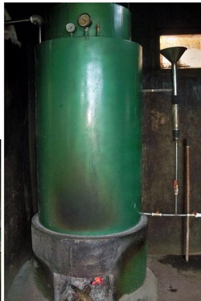
**Gambar 1. Ketel uap untuk industri tahu yang telah dioperasikan**
