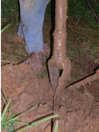
Gambar 2. Kegiatan pengeboran untuk menanam batang elektroda.
