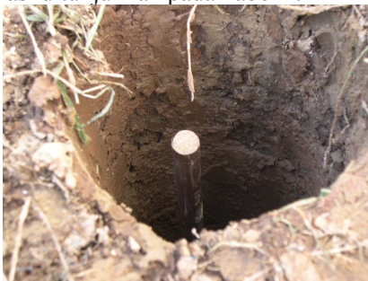
Gambar 3. Penanaman batang elektroda tunggal
