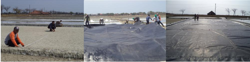
**Gambar 4. Kegiatan pemasangan geomembran HDPE**
