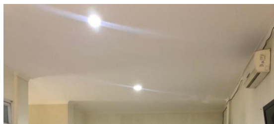
Gambar 5. Plafon Panti Werdha Wisma Mulia Jakarta Barat Sumber : Dokumentasi Pribadi (2021)
