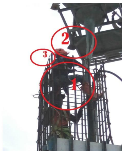
Gambar 2. Lokasi Kerja yang Berisiko Terjadinya Kecelakaan Kerja
