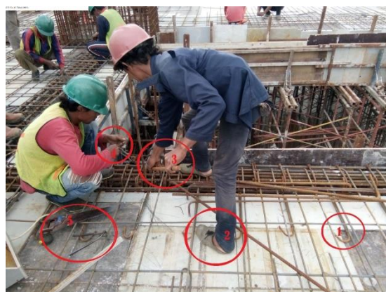
Gambar 1. Lokasi Kerja yang Berisiko Terjadinya Kecelakaan Kerja
