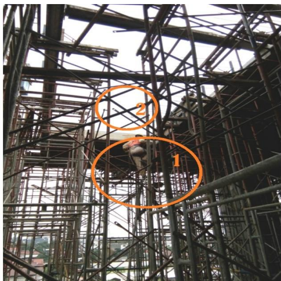
Gambar 3. Lokasi Kerja yang Berisiko Terjadinya Kecelakaan Kerja
