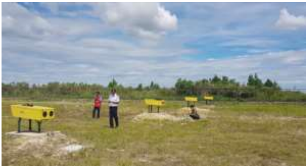
Gambar 2. Posisi PAPI di landasan terdapat 4 box
