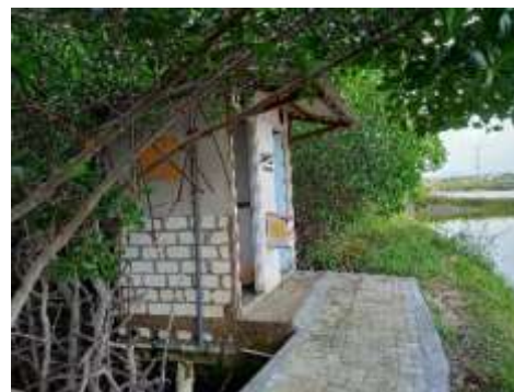
Gambar 5. Kondisi toilet di ekowisata hutan mangrove Desa Pasarbanggi Rembang
