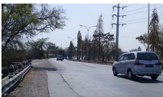
Gambar 7. Jalan Arteri Yos Sudarso Tidak Ada Rambu Tikungan
