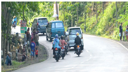
Gambar 1. Kondisi Ruas Jalan Krumpit (Sumber: Data Sekunder)
