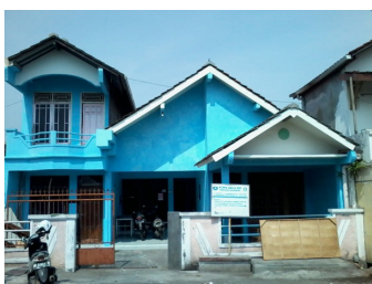
Gambar 4. Klinik Griya Asa (Sumber: Dokumentasi penulis, 21 Februari 2016)
