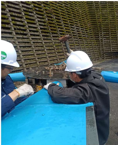
Gambar 16. Proses Pemasangan Blade
