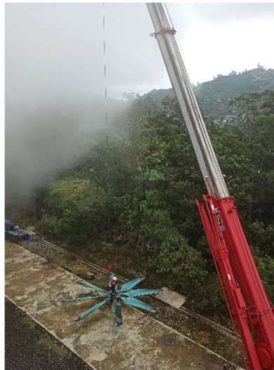
Gambar 10. Axial Fan Setelah Selesai Diangkut Crane
