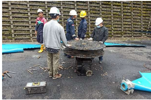
Gambar 11. Diskusi Sebelum Pemasangan
