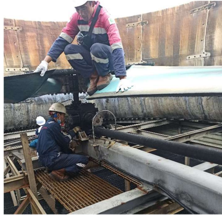
Gambar 4. Selesai Perbaikan Sudu
