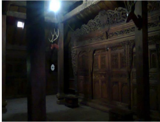
Gambar 3 Pintu penyekat antara ruang depan dengan ruang dalam/ gedhongan
