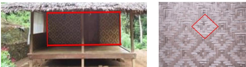
**Gambar 5.** (a) Sisi depan dinding; (b) Anyaman dinding
