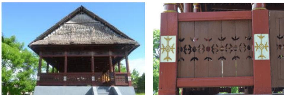
**Gambar 5.** (a) Dinding Baileo tampak depan (b) Ornamen ukiran pada dinding Baileo
