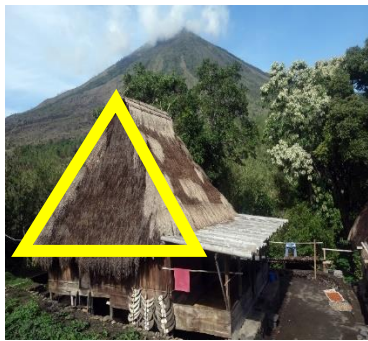
Gambar 6. Atap Rumah Adat Bajawa tampak samping
