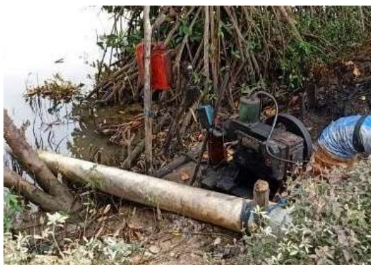
Gambar 8. Pipa menuju sungai
