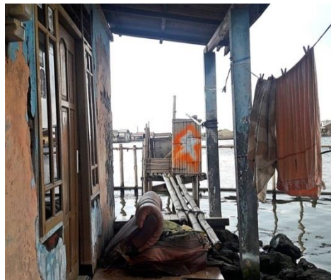
Gambar 3. Kondisi Jamban Cemplung Umum di RW 16 (Sumber: Dokumentasi Penulis, 2017)
